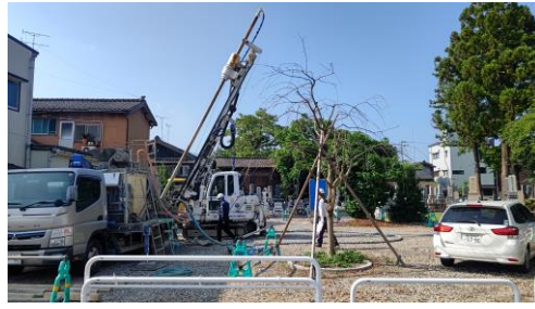
合祀墓 地盤改良工事
