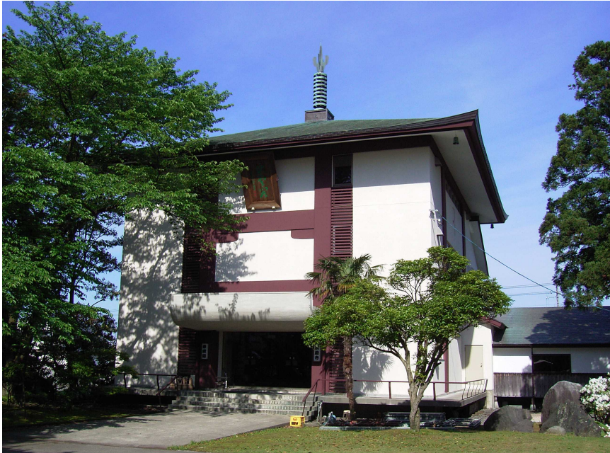
乗雲閣（位牌堂）外壁工事終了
