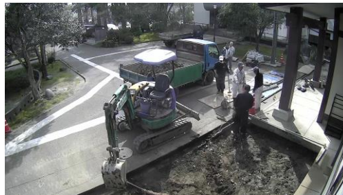
本堂前石板敷設工事
